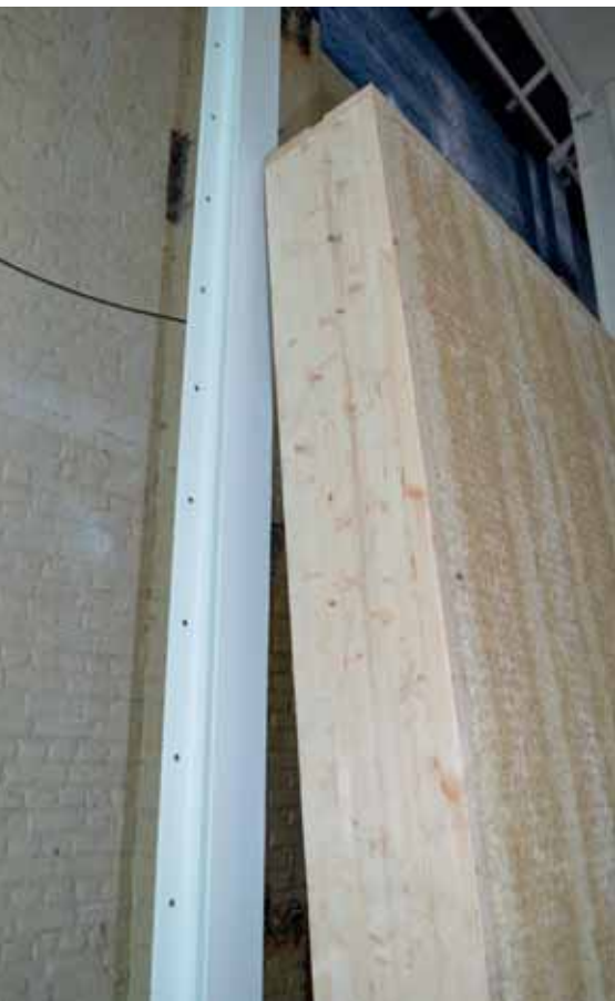
De kalkhennep-panelen van Hemp In A Box voor Depot Rato zitten in een houten kader en worden aan een staalstructuur bevestigd.
